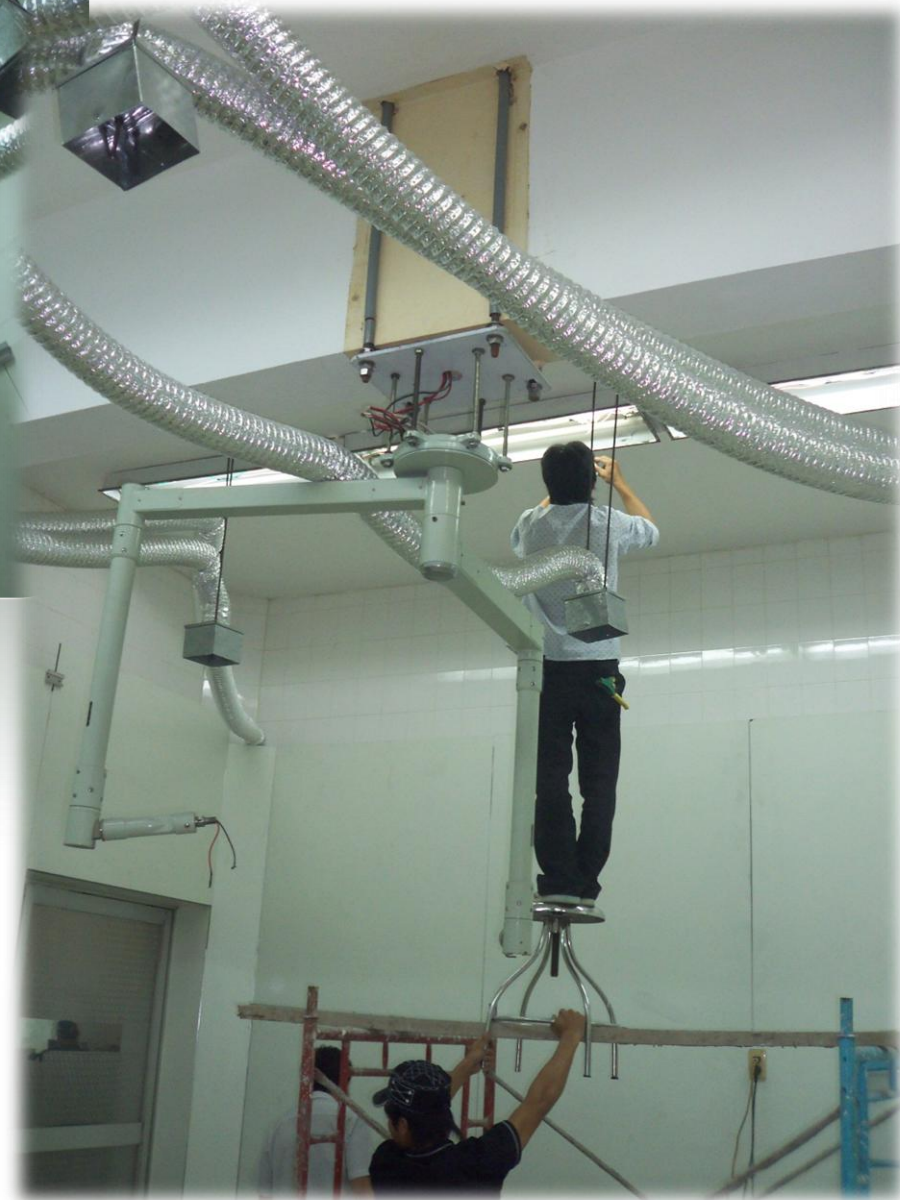
GIAI ĐOẠN LÀM KHUNG LẮP RÁP HỆ THỐNG
