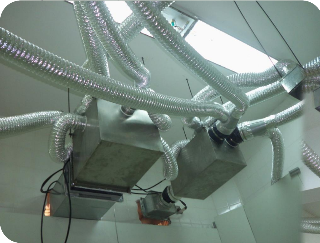
GIAI ĐOẠN LÀM HỆ THỐNG ỐNG PHÂN PHỐI KHÍ VÀO CÁC PHÒNG MỒ
